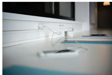
Cheminement de câbles
